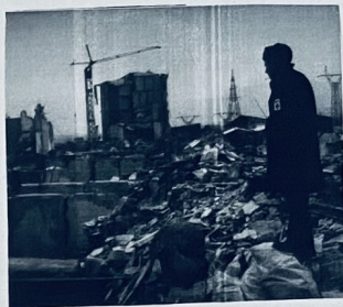
Люди, которые пережили землетрясение, будут помнить, как разрушения, как и психологические.
